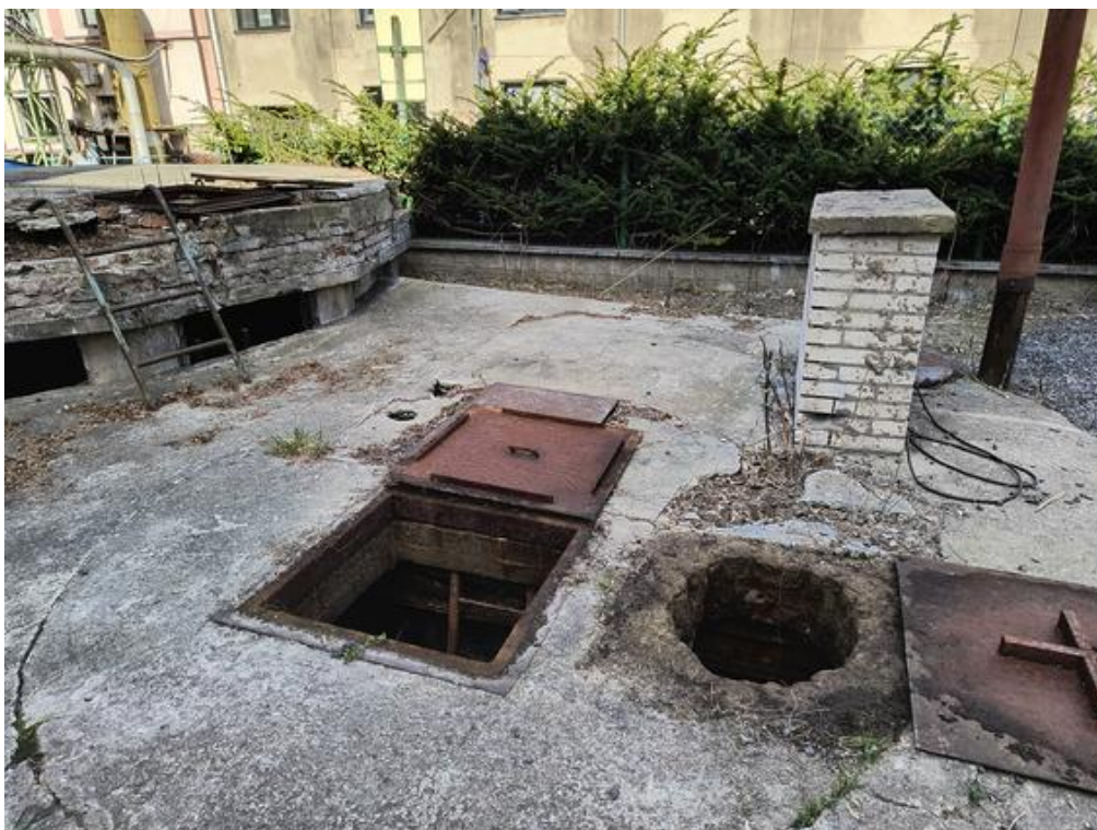
Obrázek 2: stropní betonová deska se vstupy, oba přední otvory vedou do šachty k vrtům
