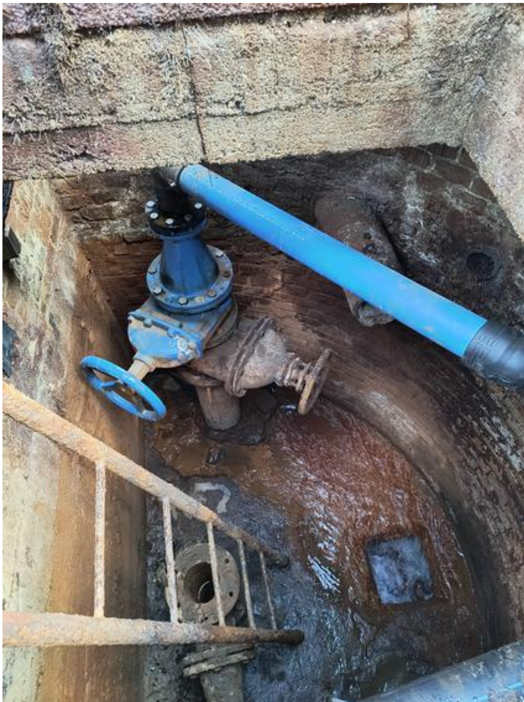
Obrázek 4: pohled do šachty s vrtu (pravá strana), viditelné je zhlaví starého vrtu ML-1 i havarovaného vrtu ML-2 s uzávěr, výtlačné potrubí (modré), kanalizační vpust ve dně s proudící vodou z havarovaného vrtu
