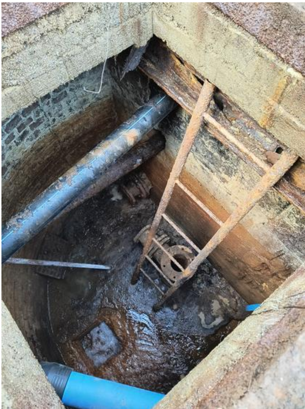
Obrázek 3: pohled do šachty s vrty (levá strana), viditelné je zhlaví starého vrtu ML-1, kanalizační vpust ve dně s proudící vodou z havarovaného vrtu a množství trubek v prostoru šachty
