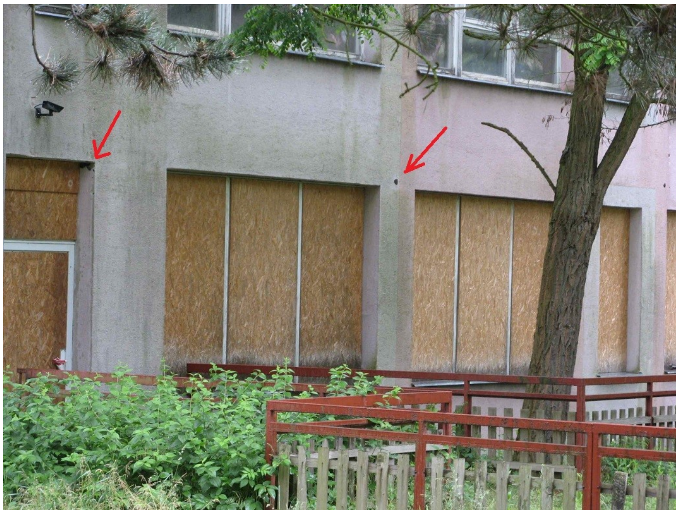
Obr. 6: další poškození fasády na jižní straně domu
