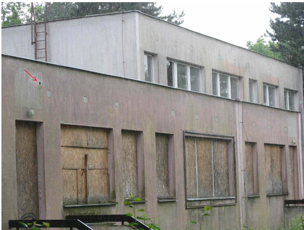
Obr. 2: strakapoudem vyklovaný otvor ve fasádě – severní stěna domu
