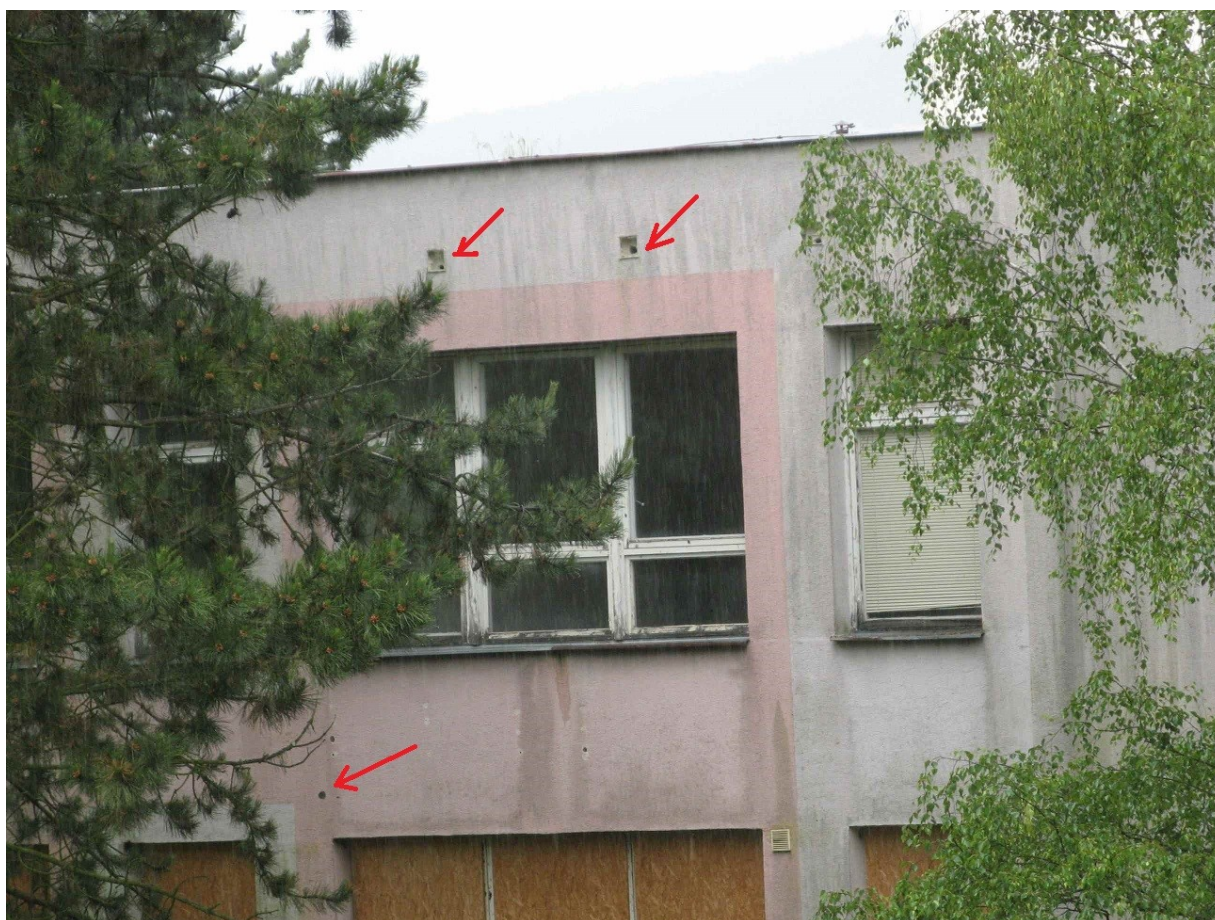
Obr. 4: chybějící mřížky na větracích otvorech a poškozená fasáda
