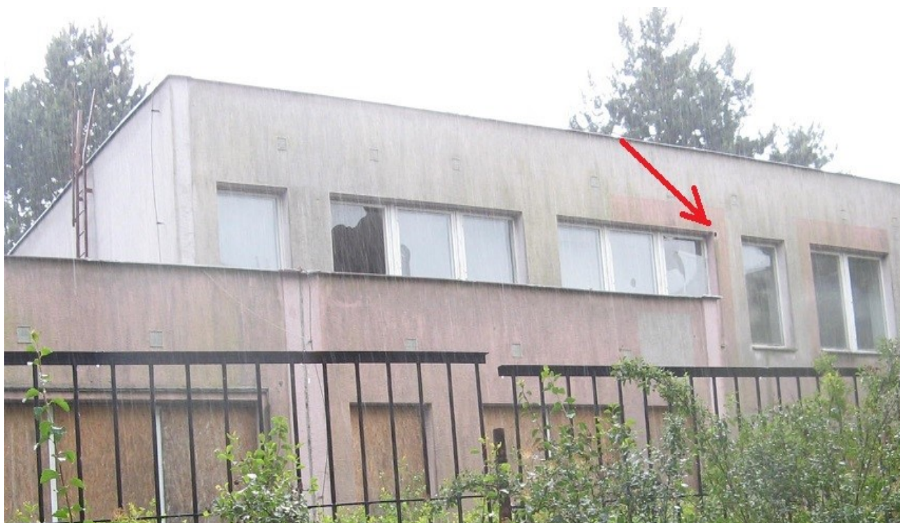
Obr. 3: další vyklovaný otvor v severní stěně v rohu okenní niky
